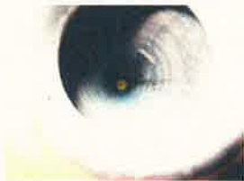
クリタイト®EK-400シリーズによる処理事例 (小型貫流ボイラ蒸発管)
